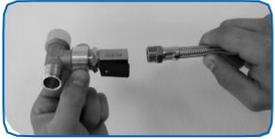
6. Avvitare il tubo flessibile nel raccordo montato sulla valvola a sfera.
